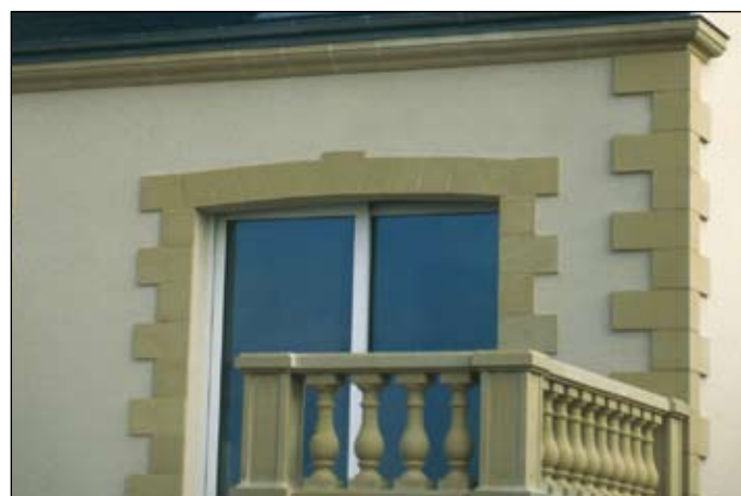
Linteau cintré réalisé par tronçonnage
